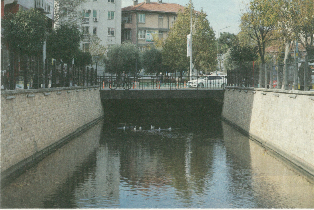
Görsel 11: Asfalt yol altında kalan çapraz köprü. (Fotoğraf: Mustafa Şahin)
